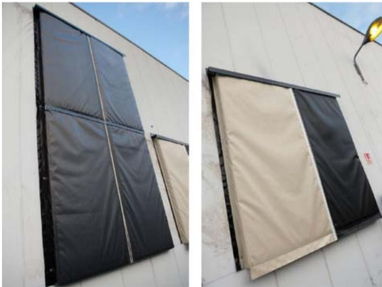
Développement par Norpac et avec des partenaires industriels de la région Nord - Pas de Calais d'un **système d'isolation thermique par l'extérieur composé d'un revêtement textile (à base de textiles recyclés)** sur ossature de fixation légère.
